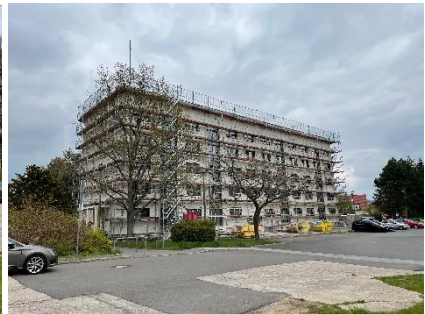
Saniertes Wohngebäude mit Tagespflege
